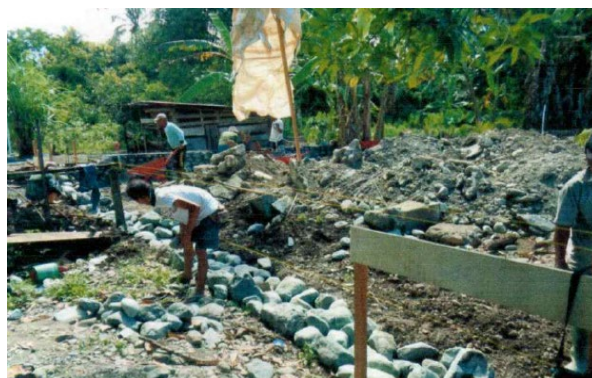
Gambar 1. Pembangunan Hamparan Jalan
